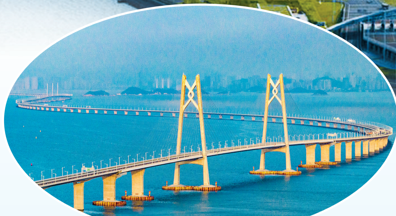
港珠澳大桥一桥跨三地。
