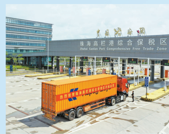
珠海高栏港综合保税区。
