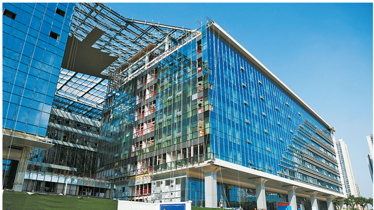
珠海市民服务中心首栋建筑装修进度已超90%。 本报记者 梁冠贤 摄
