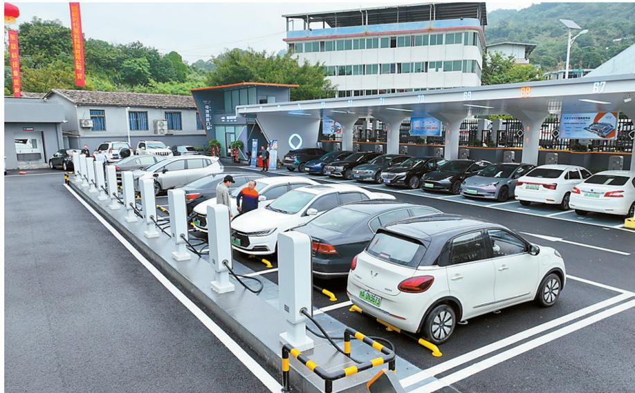
10月27日,一座集光伏、储能系统、电动汽车充放电和动力电池检测功能于一体的“光储充检”智能超充站在福建省福州市仓山区齐安路投用。
