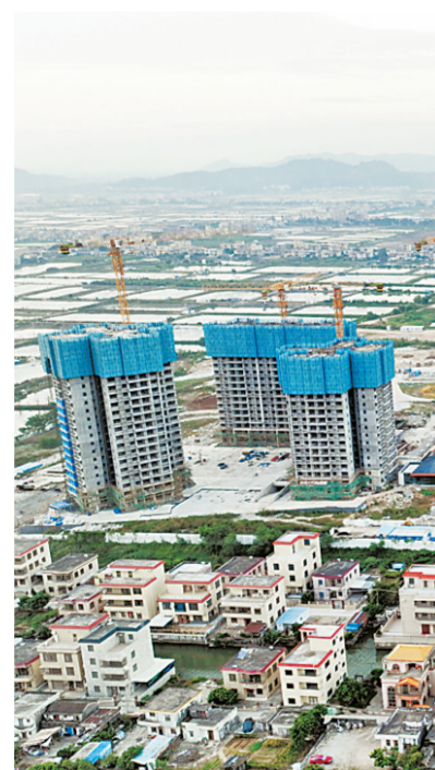
斗门区新港大道一期改造工程全长约2.3公里,车道数量由双向四车道拓宽成双向六车道。本报记者 梁冠贤 摄
