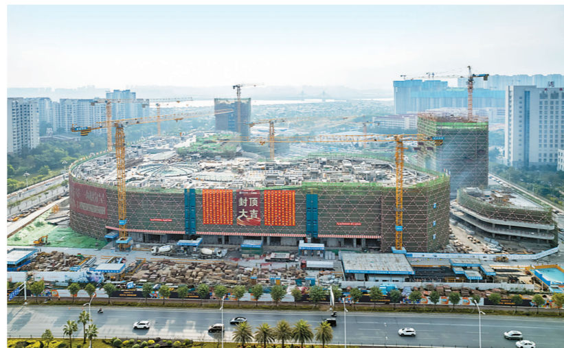
珠海·世荣万达广场项目封顶。本报记者 梁冠贤 摄
