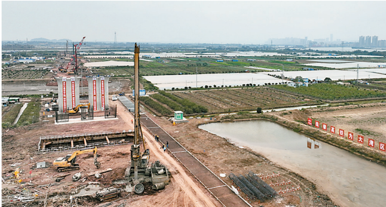
珠肇高铁珠海段部分施工现场。 本报记者 陈新年 摄
