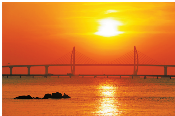
港珠澳大桥九洲航道路桥。
