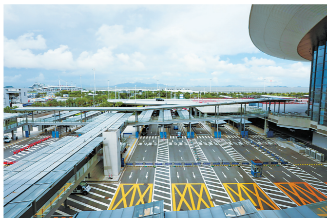
港珠澳大桥珠海公路口岸。
