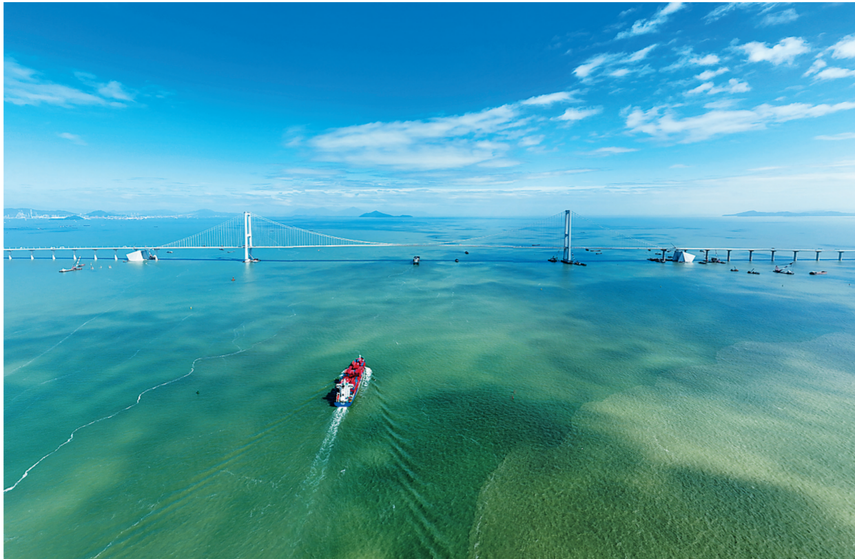
深中通道项目建设进入收尾工作阶段。 广东省交通集团供图
