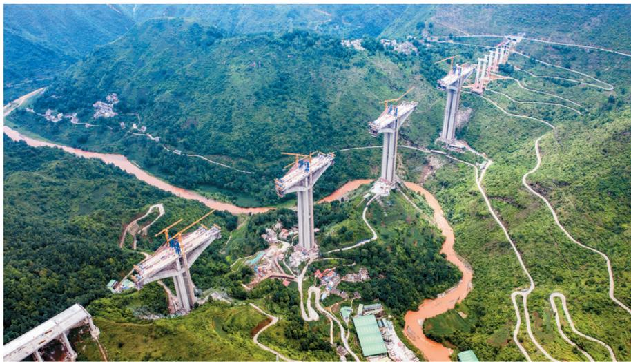
这是建设中的六枝特大桥桥墩(无人机照片,6月17日摄)。当日,随着六枝特大桥8、9号主墩空腹区交汇,由贵州交建集团所属路桥集团承建的纳晴高速六枝特大桥全桥上下弦全部完成“交会对接”,即将转入“刚构桥”施工阶段,大桥建设取得了阶段性胜利。
