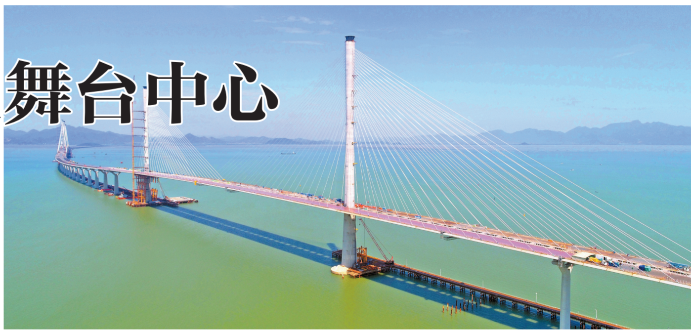
黄茅海跨海通道。
