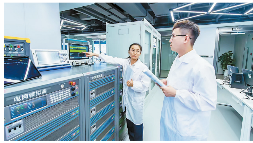
横琴数字零碳岛共享实验室配置了大容量高精度的电网模拟器,服务澳门设备厂商快速开展产品研发迭代。
