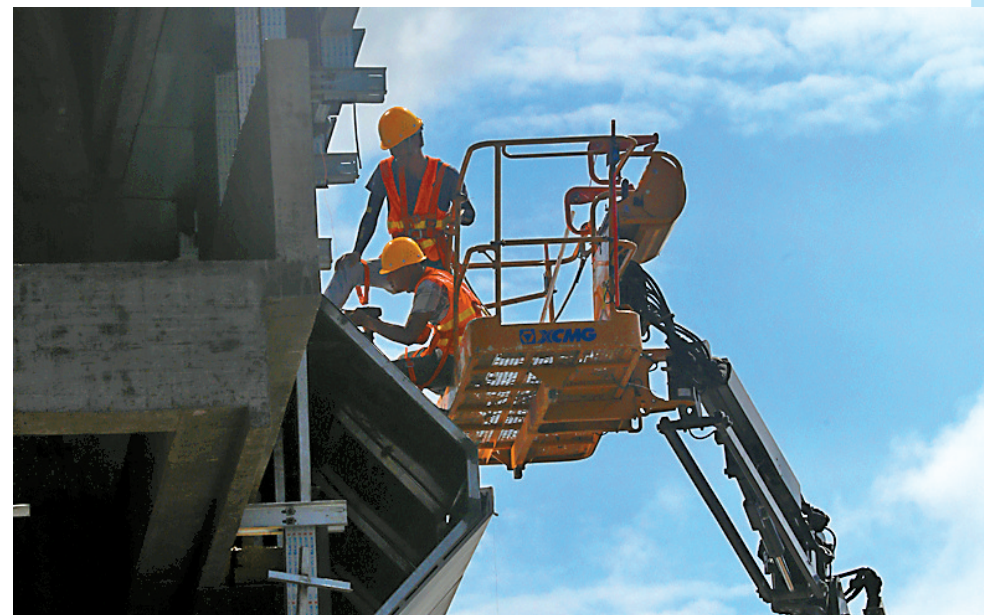
烈日当空下的珠海机场综合交通枢纽项目建设现场。
