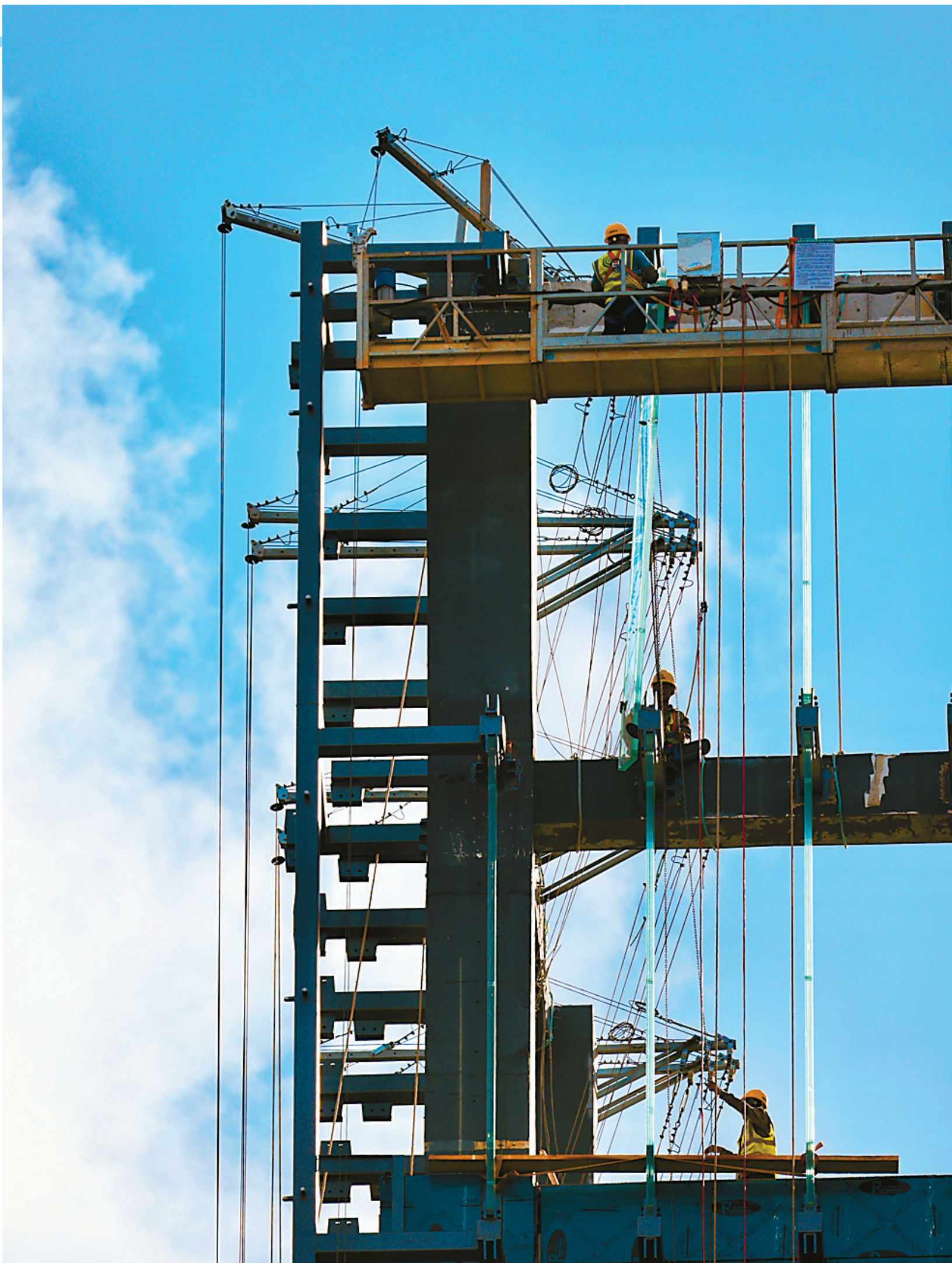
烈日之下,工人在香山场大厦顶层进行玻璃安装。
