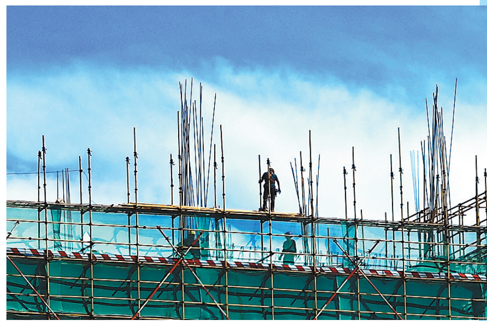
工人们冒着酷暑在珠海艺术职业学院教学楼楼顶施工。
