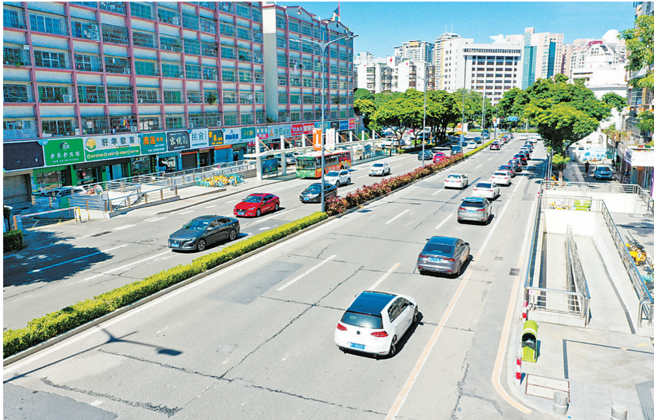
人民东路珠海二中路段施工完毕,道路恢复正常。 本报记者 赵梓 摄
