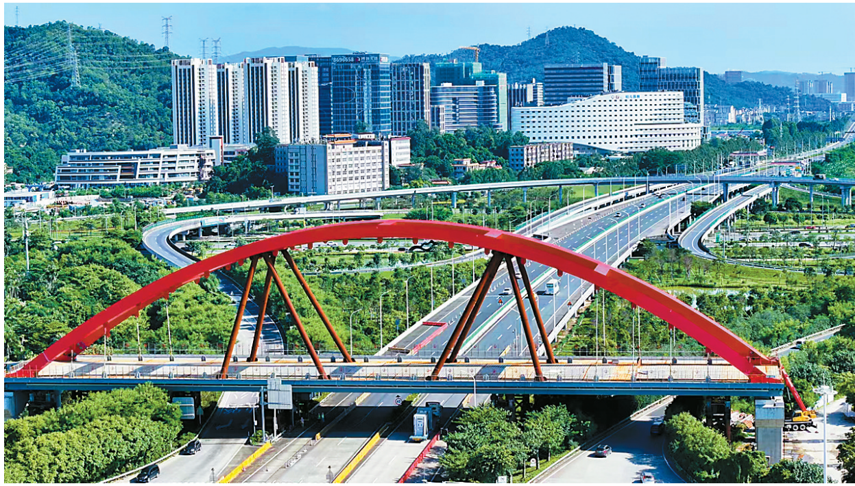
屏北一路至屏北三路跨线桥项目施工迎新进展。 本报记者 李建束 摄
