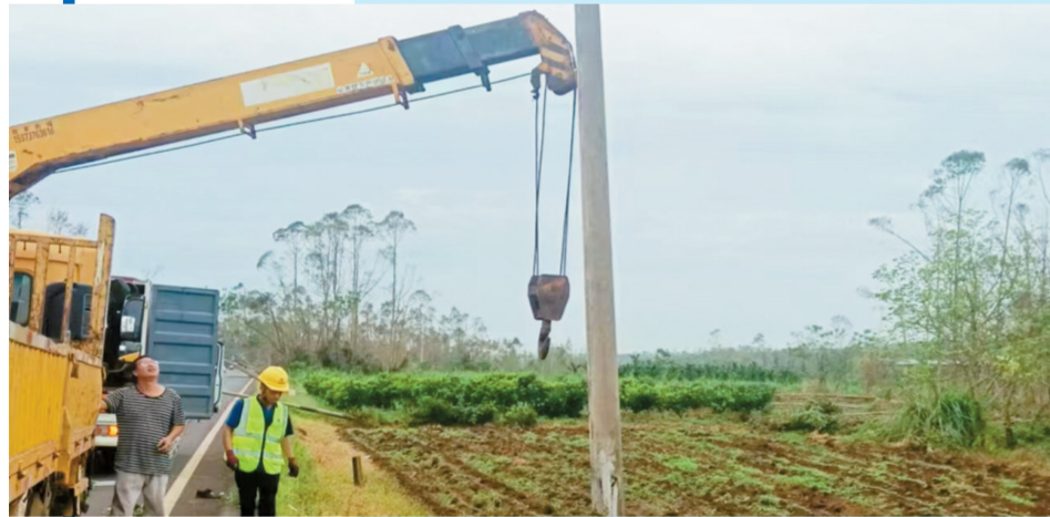
珠海电信支援队伍在海南进行通信电杆抢修。
