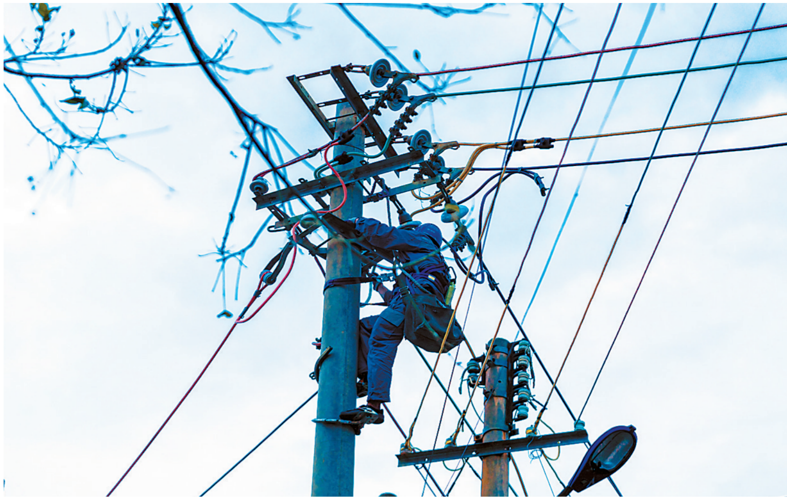
珠海供电局抢修人员在湛江角尾乡检修线路。
