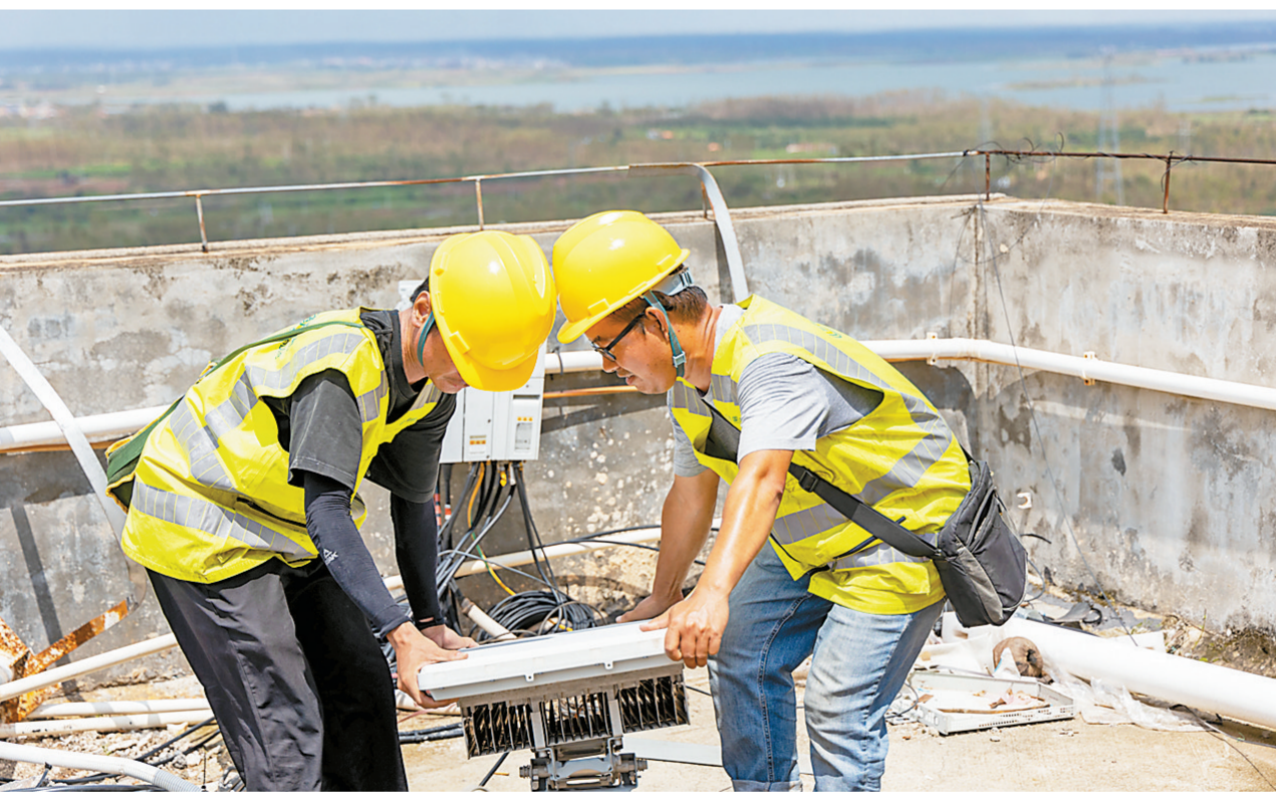
珠海移动工程人员正在抢修徐闻县木兰大道某居民楼顶的通信设备。 本报记者 梁冠贤 摄
