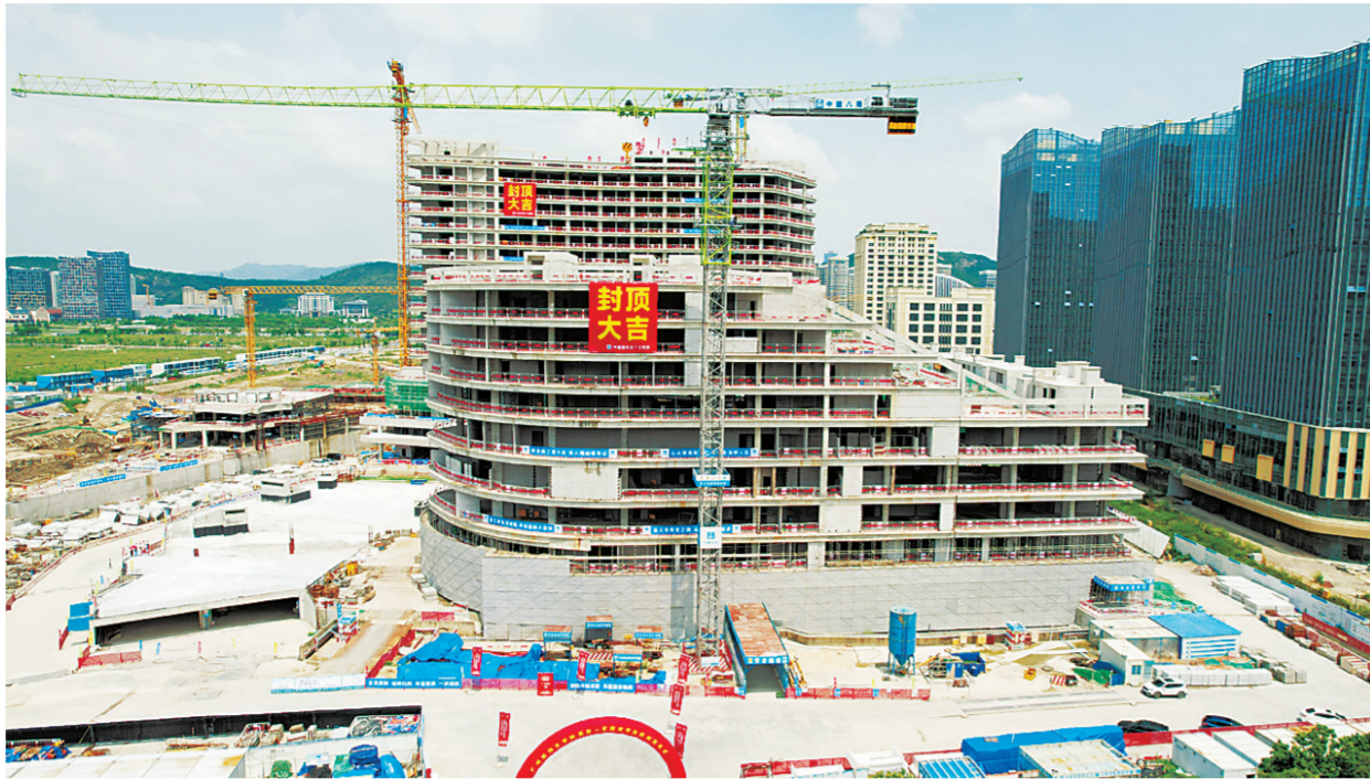
9月12日,广州医科大学附属第一医院横琴医院新院区封顶仪式现场。 本报记者 曾遥 摄
