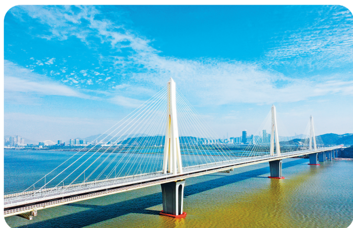
珠机城际二期重点工程珠海西江公铁两用大桥。
