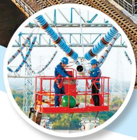
▲11月8日,在位于湖南省衡南县泉湖镇的衡阳换流站,电力工人在安装绝缘球。
