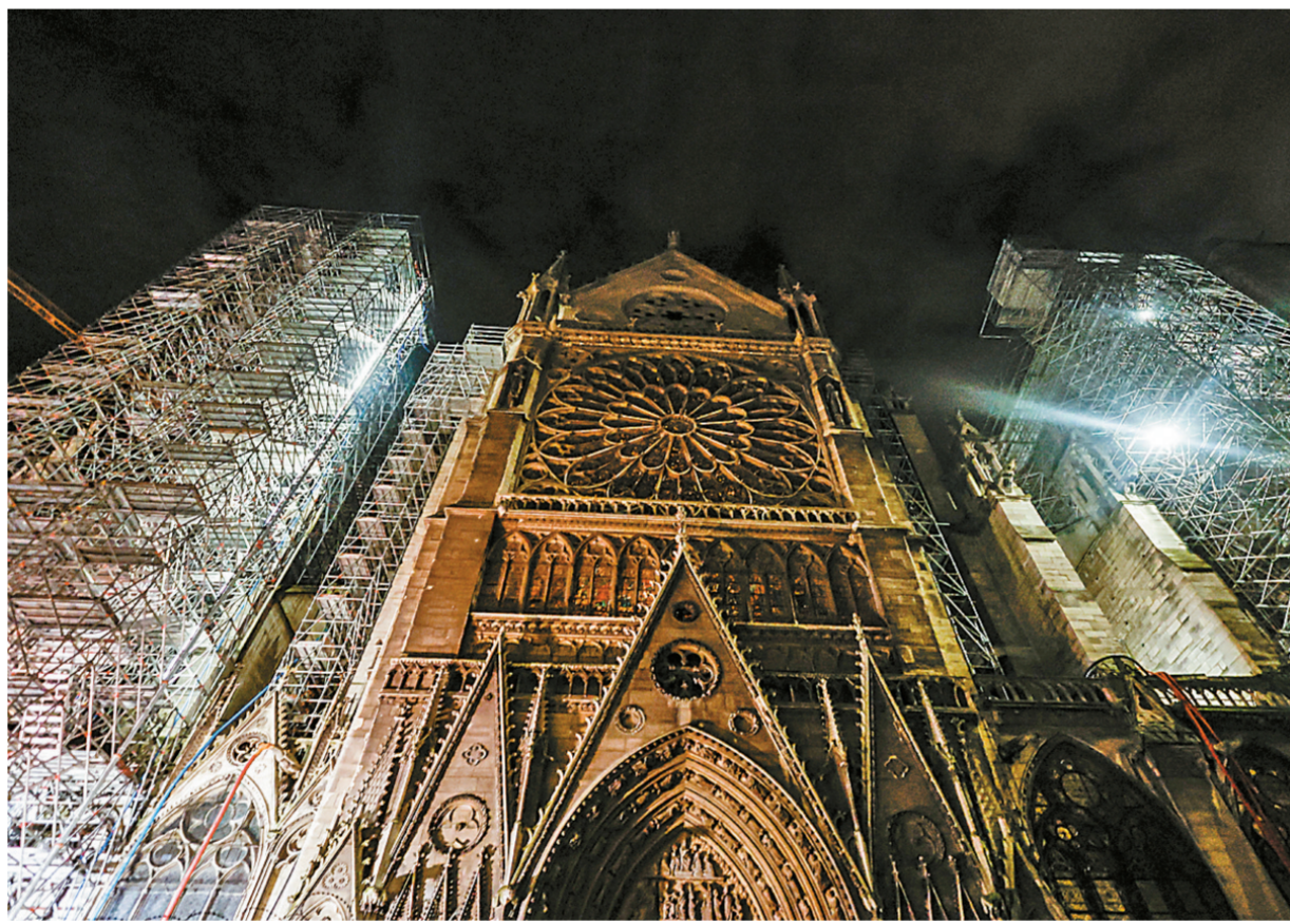
这是12月3日拍摄的法国巴黎圣母院和尚未拆除的手脚架。2019年失火的法国巴黎圣母院经过修复预计将于近日重新开放。 新华社发
