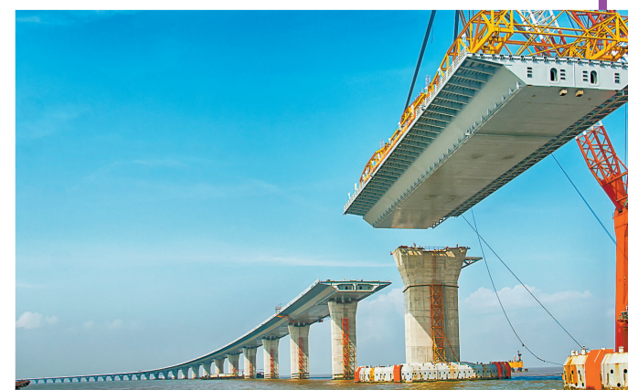
吊装黄茅海大桥钢箱梁。
