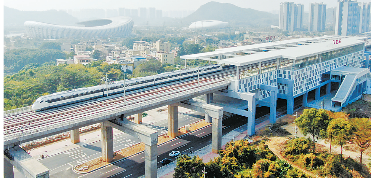
12月28日,列车驶出广清城际铁路北延线的飞霞站(无人机照片)。 新华社发
