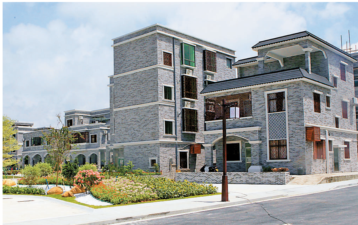
木头冲村的民宿在外观上保留了石头屋的原始风貌,内部装修精致典雅。
